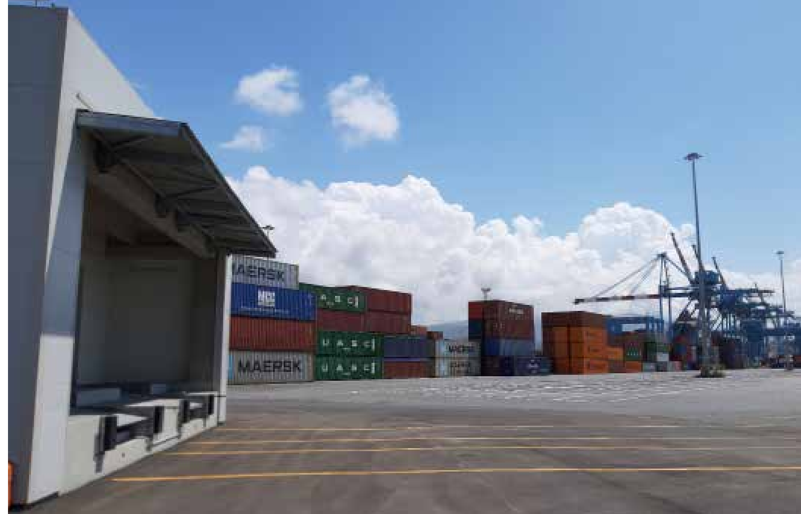
Il nuovo Posto di Ispezione Frontaliera (PIF) del porto di Genova realizzato al terminal SECH e inaugurato il 17 giugno 2020
